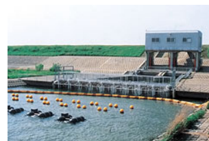
図 3.2-3 電気スクリーン
