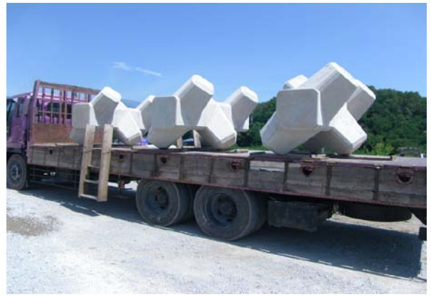
コンクリートブロック運搬状況
