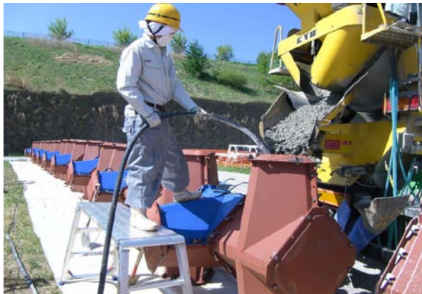
コンクリート投入状況
