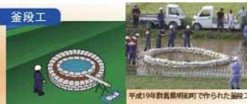
漏水の吹き出し口の周囲に何も無い場合は、吹き出し口を中心に丸く土のうを積んで、水の溜まりを作ります。
