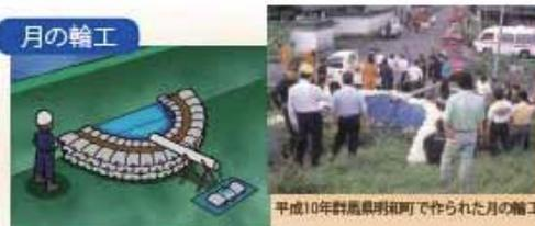
漏水の吹き出し口に堤防や建物などが近い場合、漏水口の周りに半円形に土のうを積んで、堤防や建物などを利用して漏水の溜まりを作ります。水が溜ると、漏水口に圧力がかかります。漏水の勢いが弱くなると、流し出される土砂も少なくなります。
