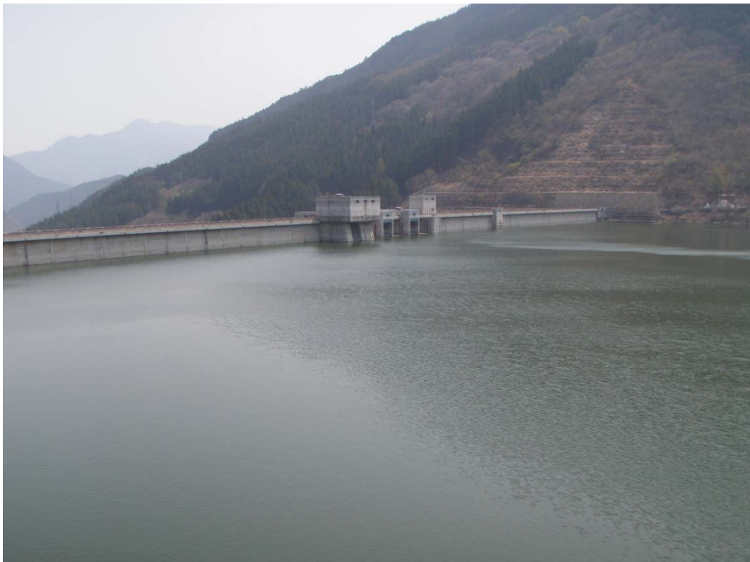
滝沢ダム(平成26年4月17日撮影)
