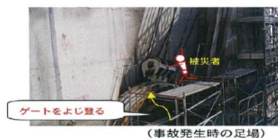
(事故発生時の足場)
