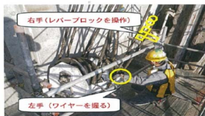
(再現用に作成した足場)
