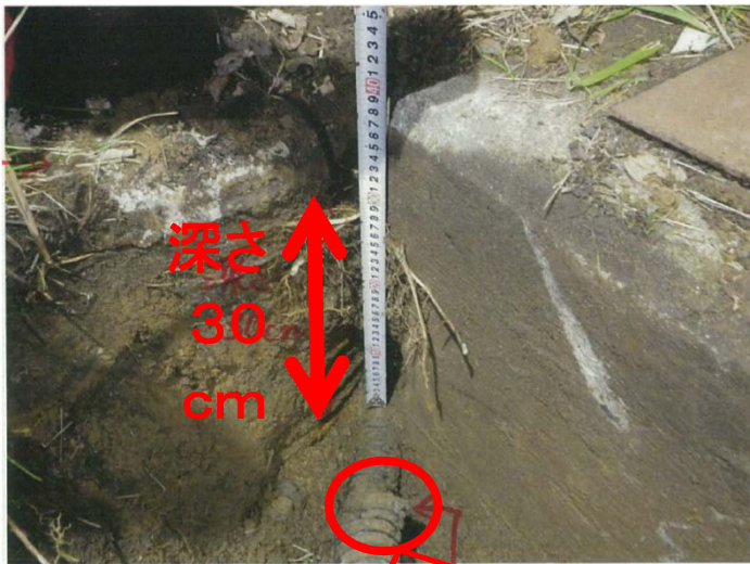
バックホウで配管を引き上げた
