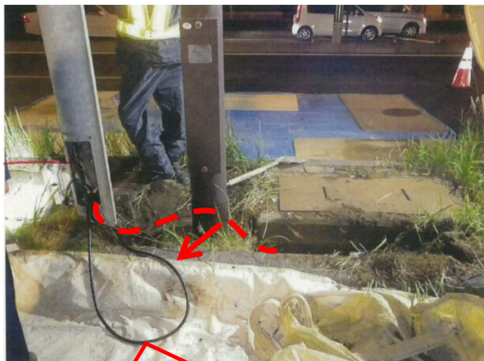
ケーブルを引き上げてしまい、端子台から外れてしまった。
