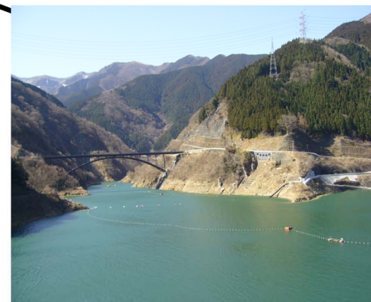
浮遊管水路工400m
