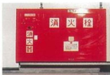
消火器・消火栓
