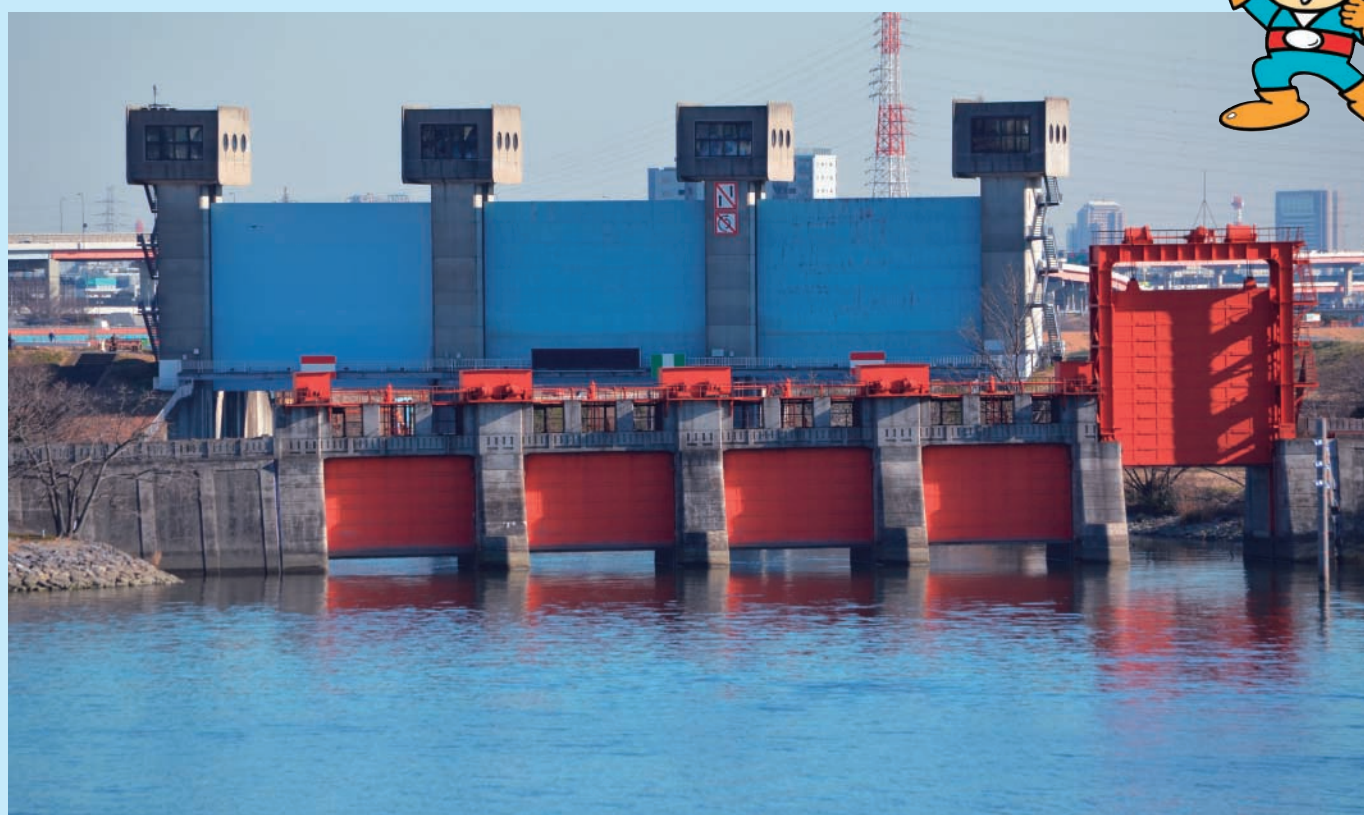
旧岩淵水門(手前、赤色の水門)と岩淵水門(奥、青色の水門)
