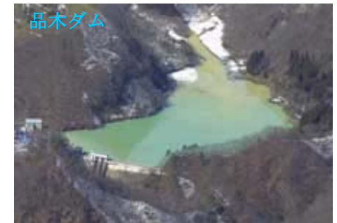
中和生成と沈殿堆積させる品木ダム
