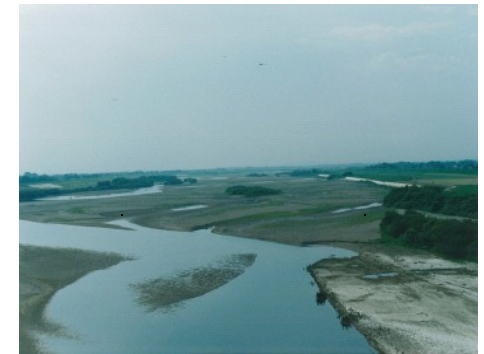
利根大堰下流砂州の露出（平成6年8月）
