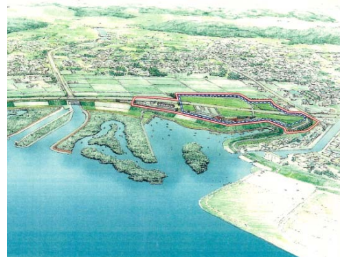
利根川下流部
