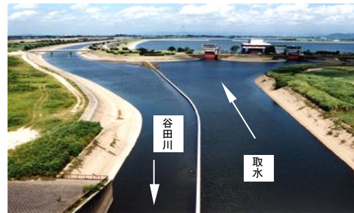
谷田川分離施設
