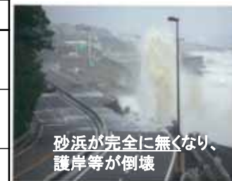
平成19年台風9号による被災状況
