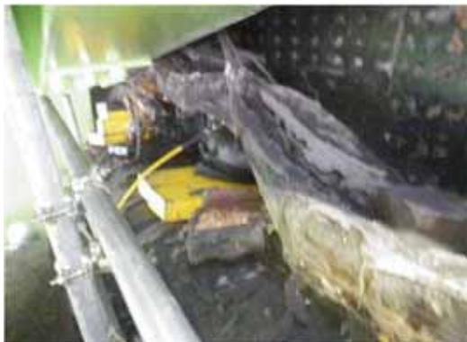
・橋脚の足場上において、作業員2人 (A・B) で伸縮装置非排水化のため、既設非排水材の撤去作業を行っていた。
