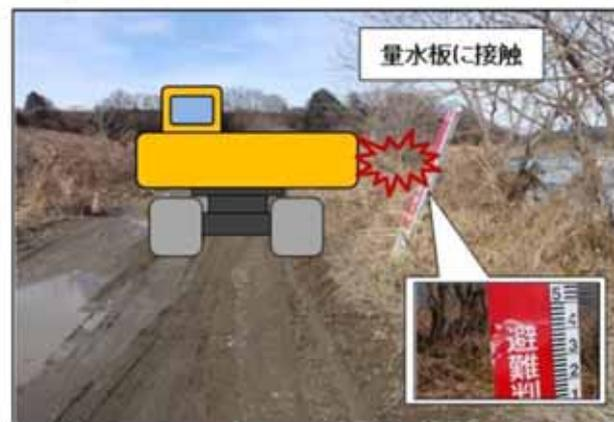
・仮設道路撤去整形をバックホウ(0.7m<sup>3</sup>)にて作業中、重機が旋回した際に量水板に気付かず、誤って重機後方部を接触させ損傷を与えた。
