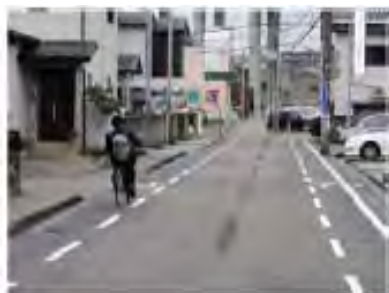
写真 I - 6 車道左側部の車線内に帯状の 路面表示を設置した事例
