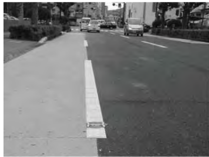
写真Ⅱ－７ 道路標示「車両通行帯」を凹凸のついた仕様とした事例
