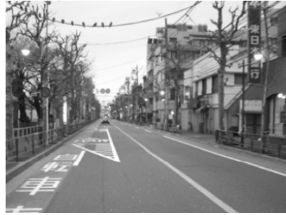
写真Ⅱ- 17 バス停を示す路面表示を設置した事例
