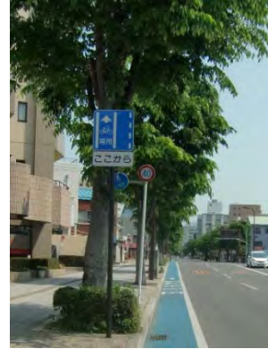
写真Ⅱ－６ 道路標識「普通自転車専用通行帯（327 の4 の2）」と道路標示「専用通行帯（109 の6）」を設置した事例
