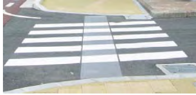
写真Ⅱ-15 横断歩道におけるエスコートゾーンの設置例
