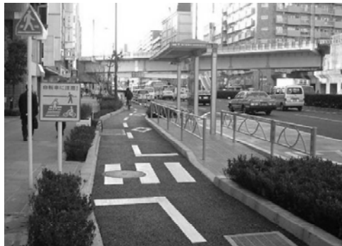
写真Ⅱ-16 交通島を設置し、道路標識及び道路標示を設置した事例
