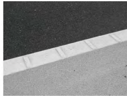
写真Ⅱ－７ 道路標示「車両通行帯」を凹凸のついた仕様とした事例
