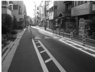
写真Ⅱ- 12 車道部分にハンプを設置しハンプの両側にゴム製ポールを設置した事例
