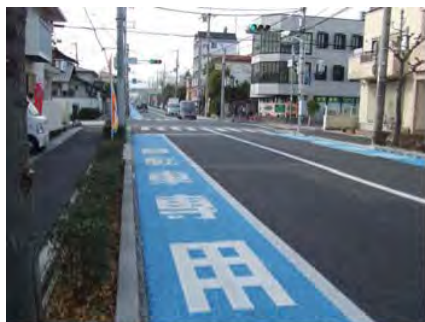
写真Ⅱ- 1 街渠をエプロン幅の狭い平坦性の高いものに置き換えた事例
