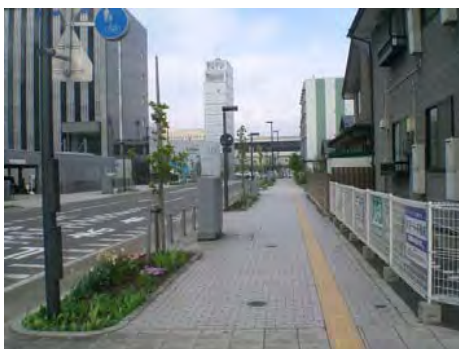
写真Ⅱ-14 視覚障がい者誘導用ブロックの設置例
