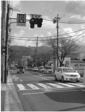
写真Ⅱ－５ 道路標識「専用通行帯（327 の4）」と道路標示「専用通行帯（109 の6）」を設置した事例
