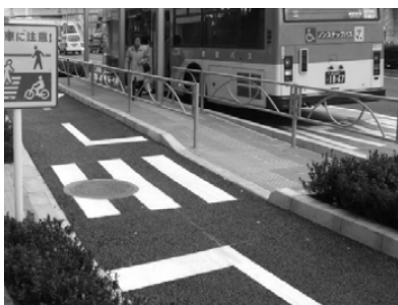
写真Ⅱ- 4 停止線を設置した事例
