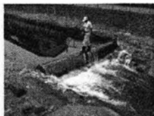
会場の下流には仮設の堰が設けられ、落合川の水深を調整していました。
