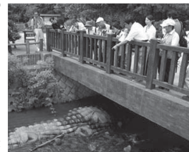
善行橋の上から魚道を見学
