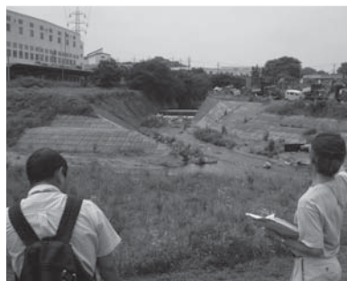
東川・柳瀬川合流点の落差工
