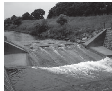
金山調節池出口の斜路式落差工
