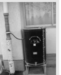
雨水貯留タンク
