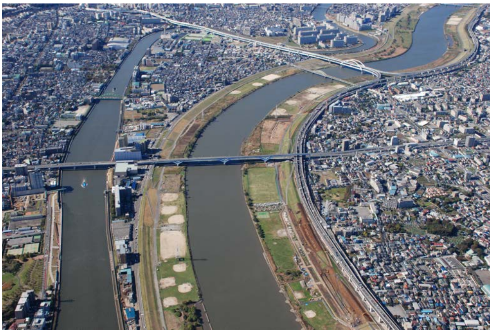
西新井・本木ブロック付近の荒川 (14.75m～17.0km)
