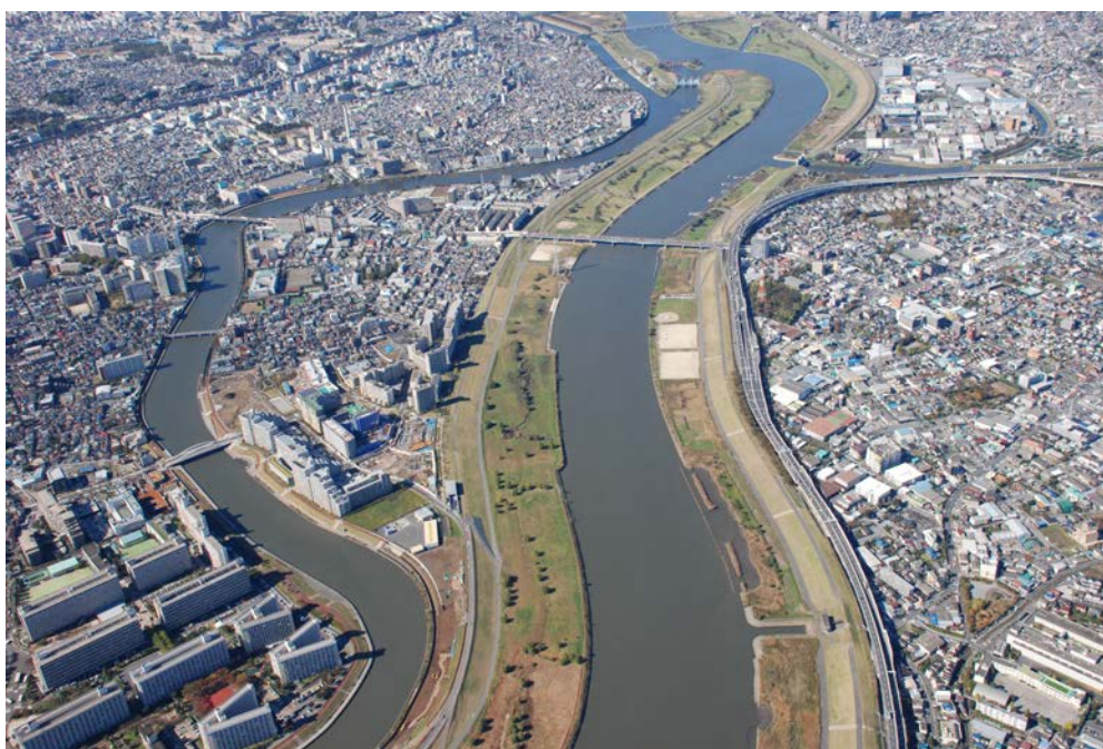
熊の木ワンド付近の護岸（17.5km～20.0km）
