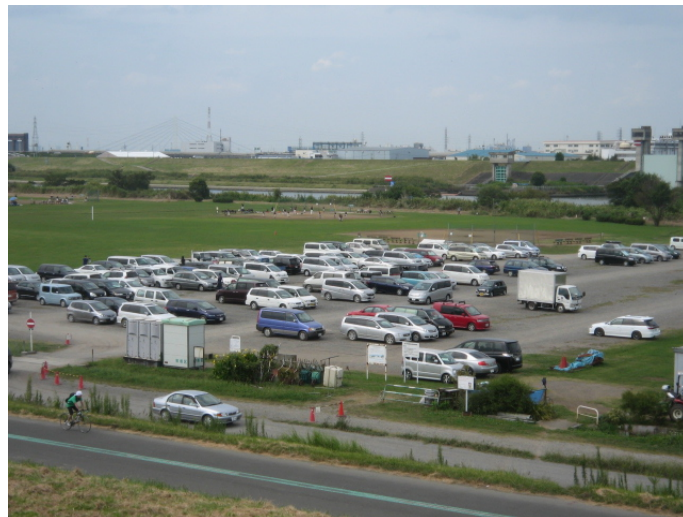
図 4-11 駐車場と緊急用河川敷道路（板橋区）
