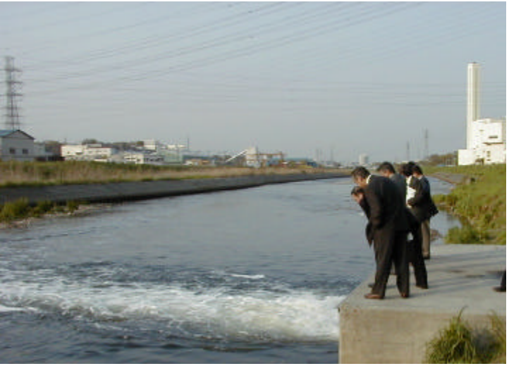
清瀬下水処理場の放流口
