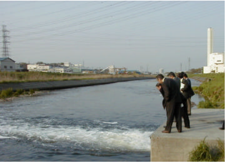
清瀬下水処理場の放流口
