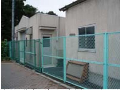
中野下住宅一体の雨水を集め、大雨時に河川へ放流する施設です。2基のポンプで毎秒約2トンの能力があります。
