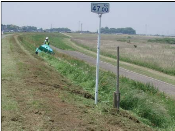
堤防草刈状況
