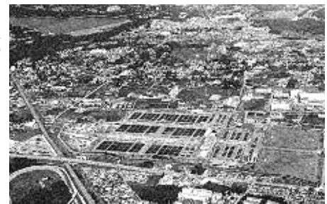
東村山浄水場全景
