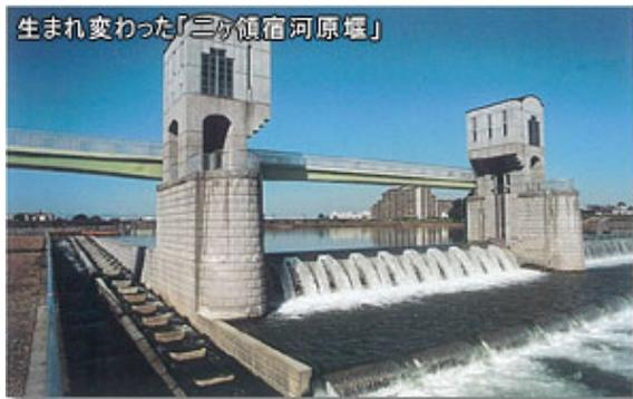
結果、越流式の旧固定堰を40m下流に移動し、洪水時起伏式の可動堰5門と、洪水時引上式スライドゲート1門の全横断の可動堰にすること、また魚道を1箇所から3箇所へ増設する事などが決定し、平成6(1994)年から着工されました。
