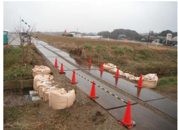
水路箇所目印設置状況
