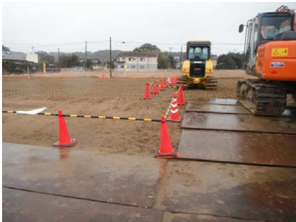
作業場所仕切り状況
