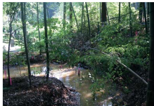
両生類の保全のための代替池を造成
