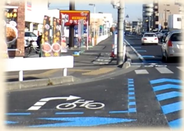
図3 二段階右折時の滞留スペース確保の対策例
