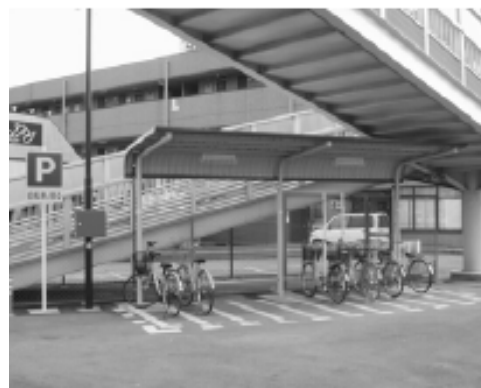
(宇都宮市) 写真 I- 4 駐輪施設
