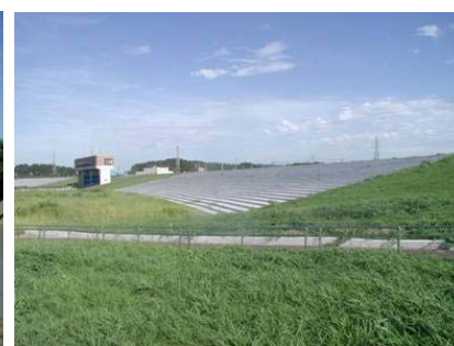
<小野川放水路と緩傾斜堤防>
