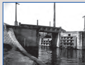
小名木川閘門 大正8年着工 昭和2年完成（本体部分は大正13年に完成） 昭和51年撤去
