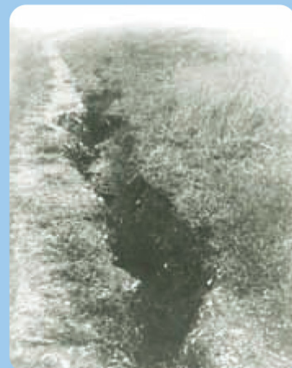
堤防がさけるなどの被害がありました
