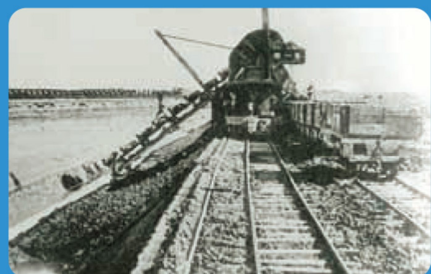
水路をほる機械・エキスカベーター
