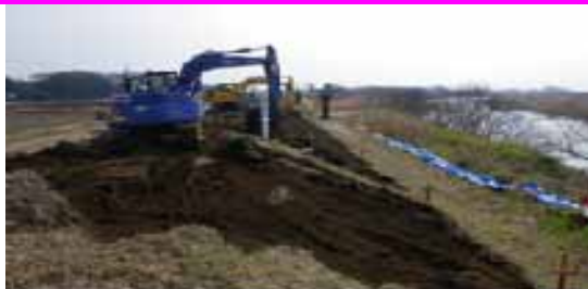
小貝川左岸42. 0k付近 茨城県つくば市安食地先
