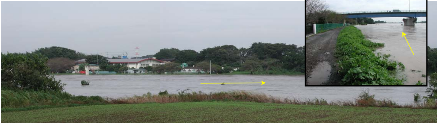
鬼怒川 筑西市下川島地先 左岸 45.6k付近
