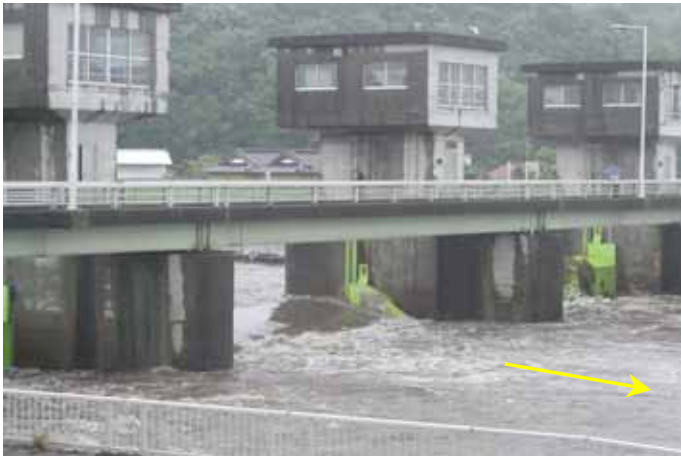
小貝川75.9k付近 君島堰 (真岡市須釜地先)
