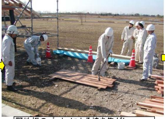
野地板のバーナーによる焼き焦がし
