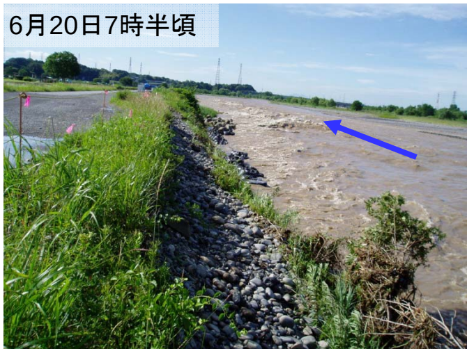
鬼怒川 左岸84.5k付近
