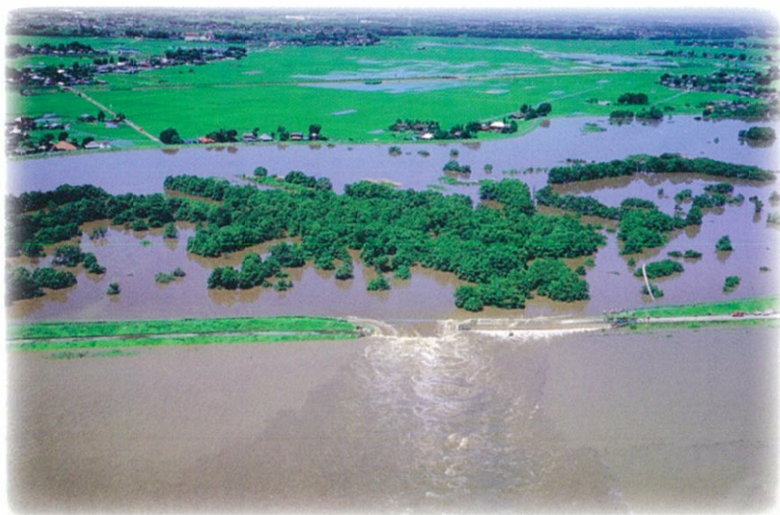
昭和 61 年 8 月 5 日 台風 10 号による決壊 旧明野町赤浜地先 河川空間の活用
