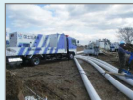
名取川周辺での排水作業状況
