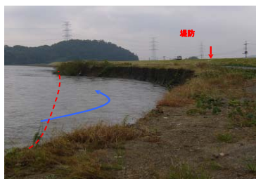
洪水流により堤防直近の河岸が洗掘 (平成16年洪水 栃木県真岡市)
