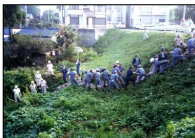
漏水発生時の水防団による月の輪工法 実施状況
