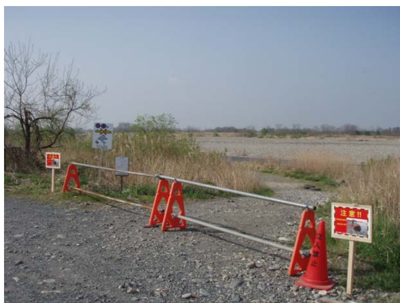
注意看板の設置、バリケートの追加
