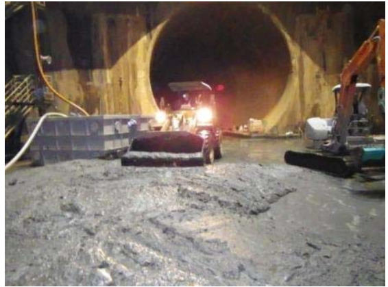
トンネル内の土砂撤去
