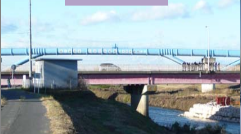
越流堤を見学
