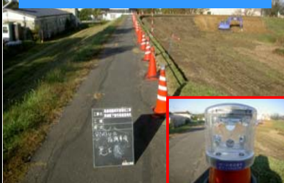
安全確保のため路肩のカラーコーン上部に設置された保安灯
