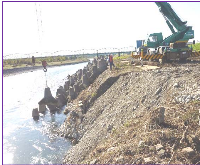
石井出張所管内では、台風15号の洪水で洗掘された災害箇所の応急復旧工事が始まりました。
