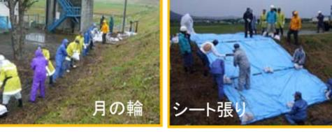
小貝川右岸49.8k 上野2号排水樋管付近 筑西市水防団による漏水対策(22日17:30)
