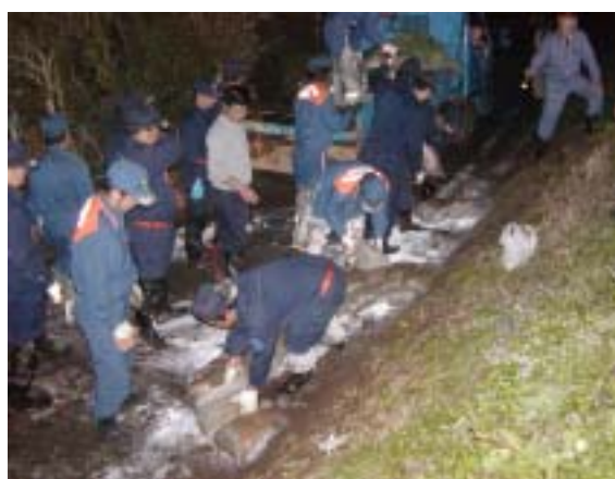
平成16年10月出水時：月ノ輪工法を実施
