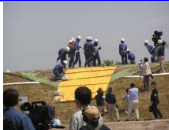
シート張り工法を実施する水防団員 54th利根川水系連合水防訓練より
