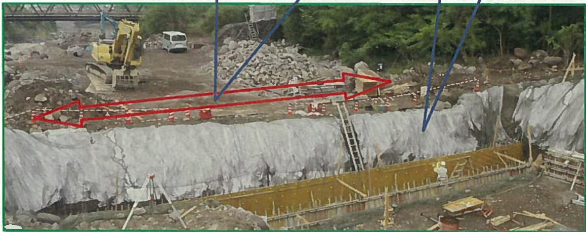
【 写真-1 透明シート張付け後、落石防護ネットを設置 】
