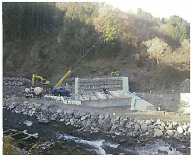
床固め工全景
