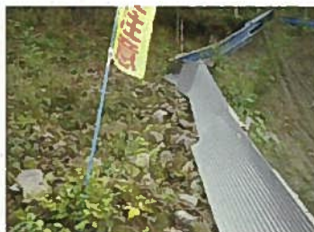
波板による落石対策
