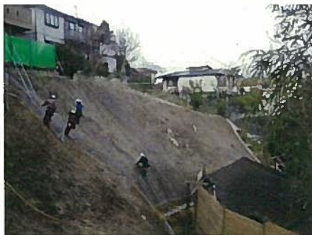
写真 3-1 法面作業状況
