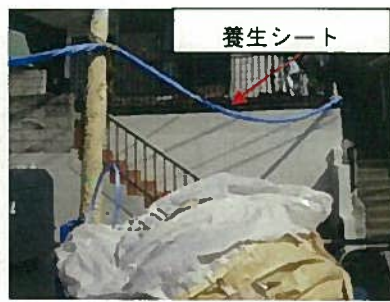
写真 2-5 ホースの養生
