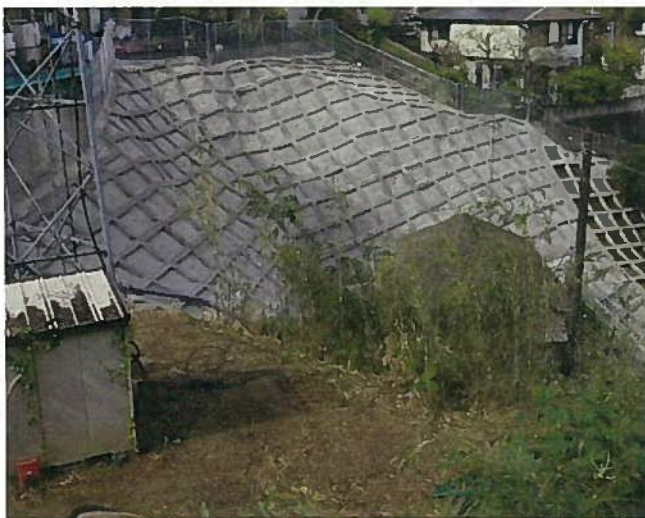
写真 1-1 工事完成状況
