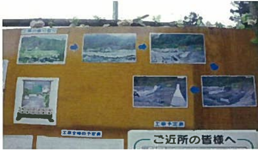
進捗状況写真
