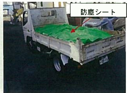
写真 2-3 残土飛散養生
