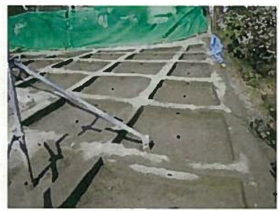
写真 2-6 モルタル飛散養生
