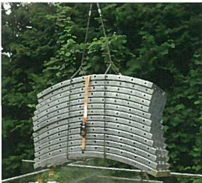
（写真・10）吊り荷見直し前
