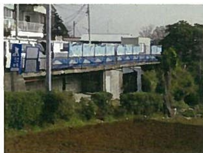
写真 2-4 目隠しシート
