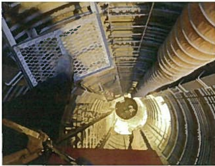
（写真. 13）坑内降り場の隙間
