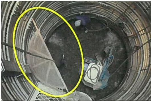
（写真・8）半月板設置状況
