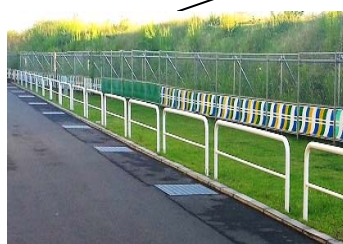
既設ガードパイプ
