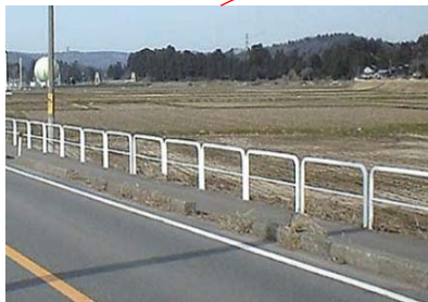
ガードパイプ
