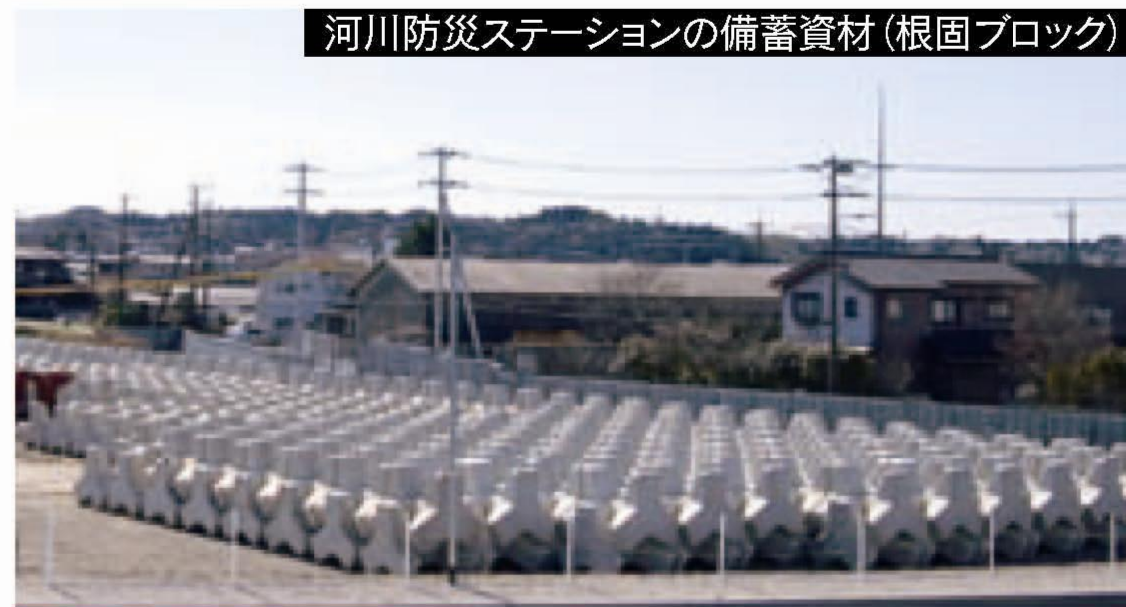
河川防災ステーションの備蓄資材(根固ブロック)
