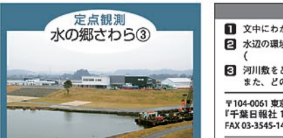
まもなく完成予定の緩勾配式魚道(左)と呼び水式階段魚道(右)
