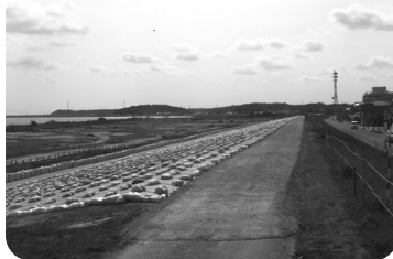
応急復旧状況
