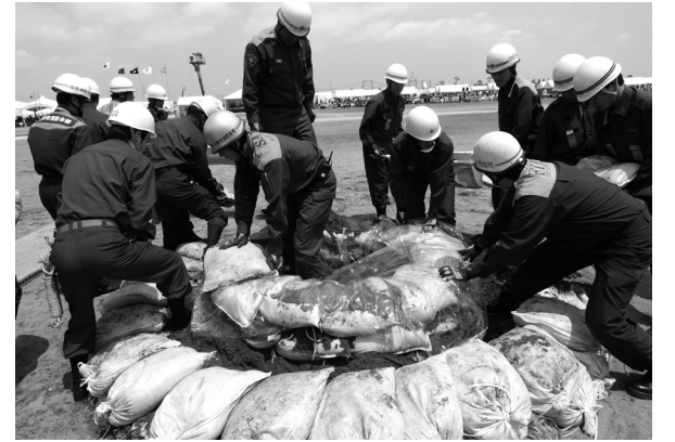
平成20年に栄町で行われた第57回利根川水系連合水防演習のようす(釜段工)
