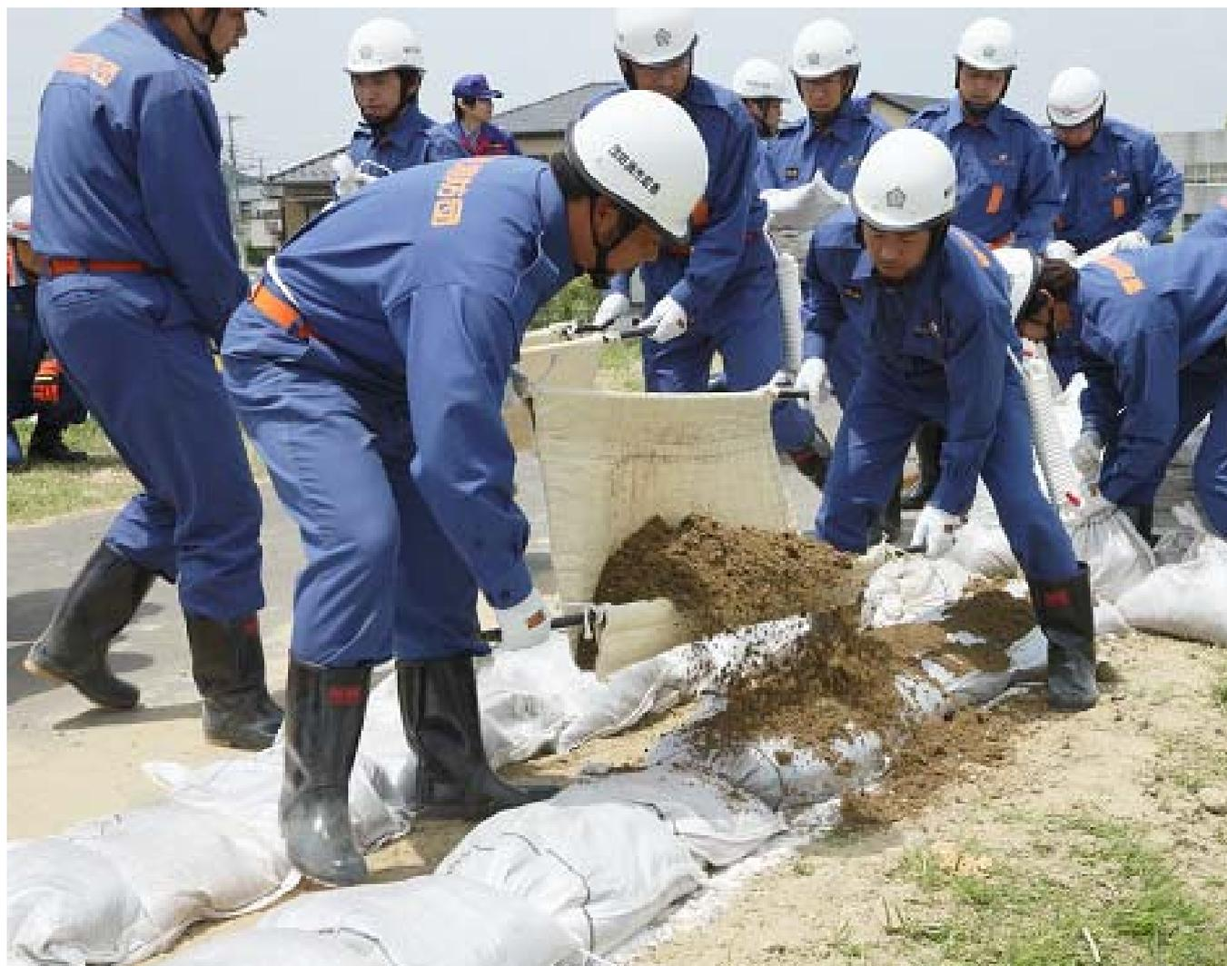
増水した河川の水が堤防を超えないようにする「積み土のう」を行う水防団
